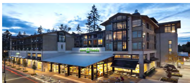
写真7 UBC：近隣住区の集合住宅（1階はスーパーマーケット）
